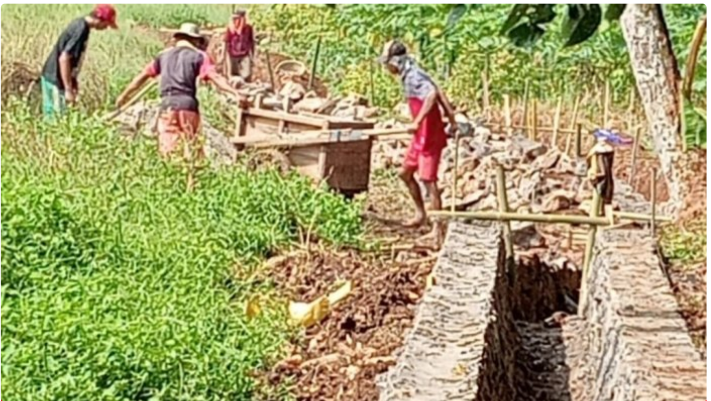
Warga Desa Banyubiru Kecamatan Labuan Bangun Drainase
