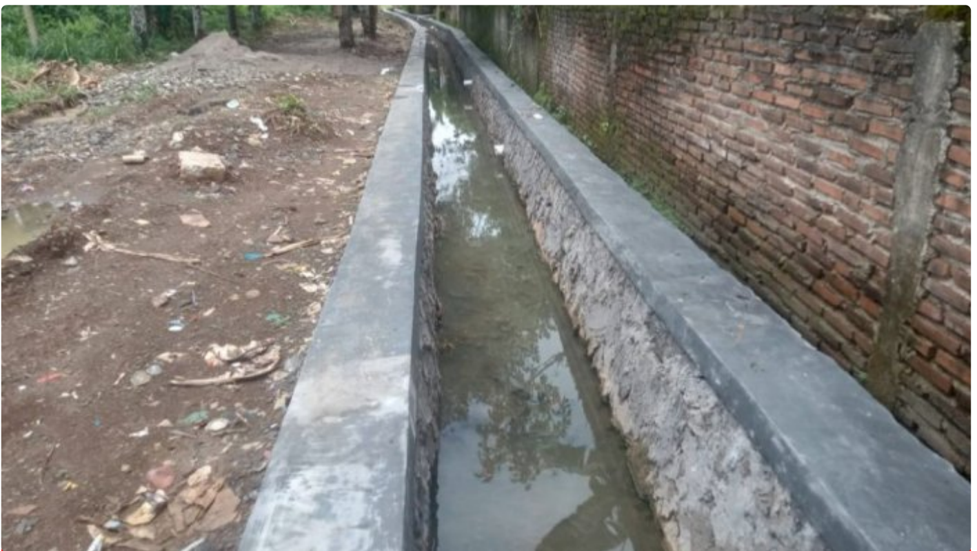
Pembangunan Saluran Drainase di Desa Sukamaju Kecamatan Labuan Tepatnya di Perumahan Griya Asri Labuan
